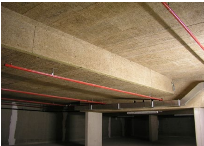
Panneaux Fibro-THERM-S avec ancrés en inox pour coffrage en béton
