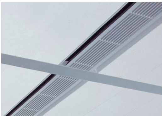
Klimatelement in OWA-Bandrastrerdecke integriert
